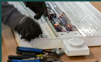
Montaż energooszczędnego oświetlenia w ramach programu Prologis Essentials LED
