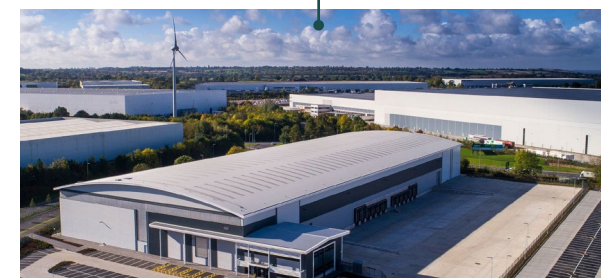
Wyróżniony oceną „Excellent” w akredytacji BREEAM Prologis RFI DIRFT w Daventry w Wielkiej Brytanii
