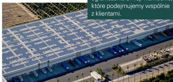
Instalacja solarna w posiadającym certyfikację LEED na poziomie Silver Prologis Park Redlands w Kalifornii
