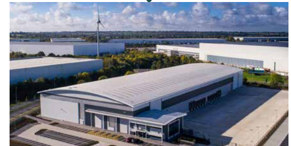
A „Kiváló” BREEAM minősítéssel rendelkező Prologis RFI DIRFT, Daventry, UK.
