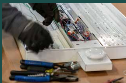
Energiatakarékos világítótestek szerelése a Prologis Essentials LED világítási program keretében
